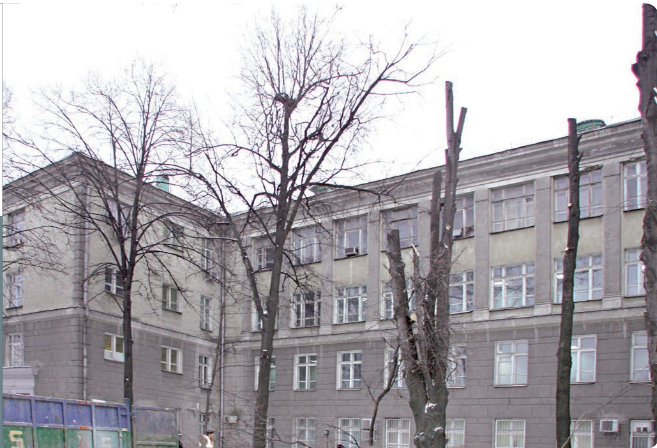
4-этажное здание школьного типа, на месте которого возведен новый учебный корпус
