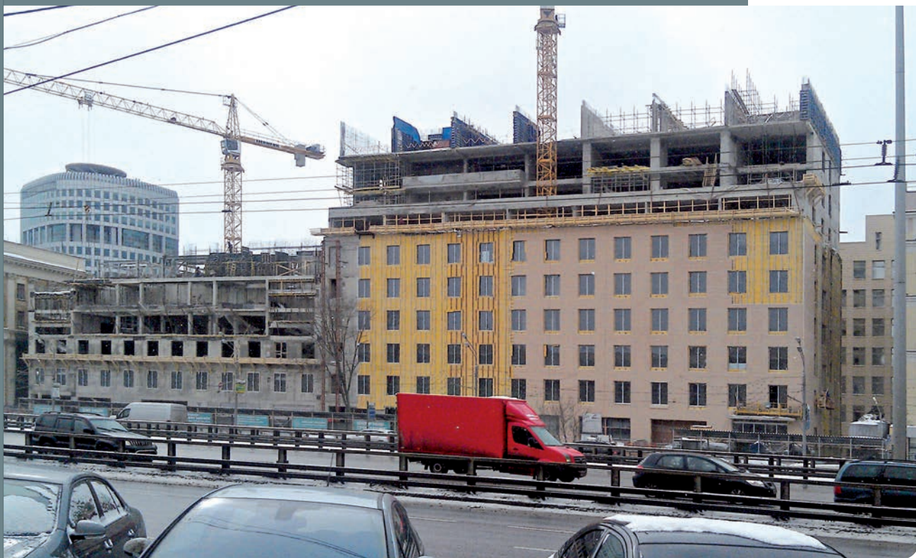
Март 2013 г. Идет строительство
