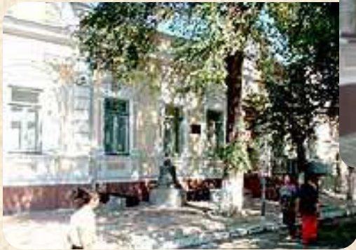
Фото здания музея
