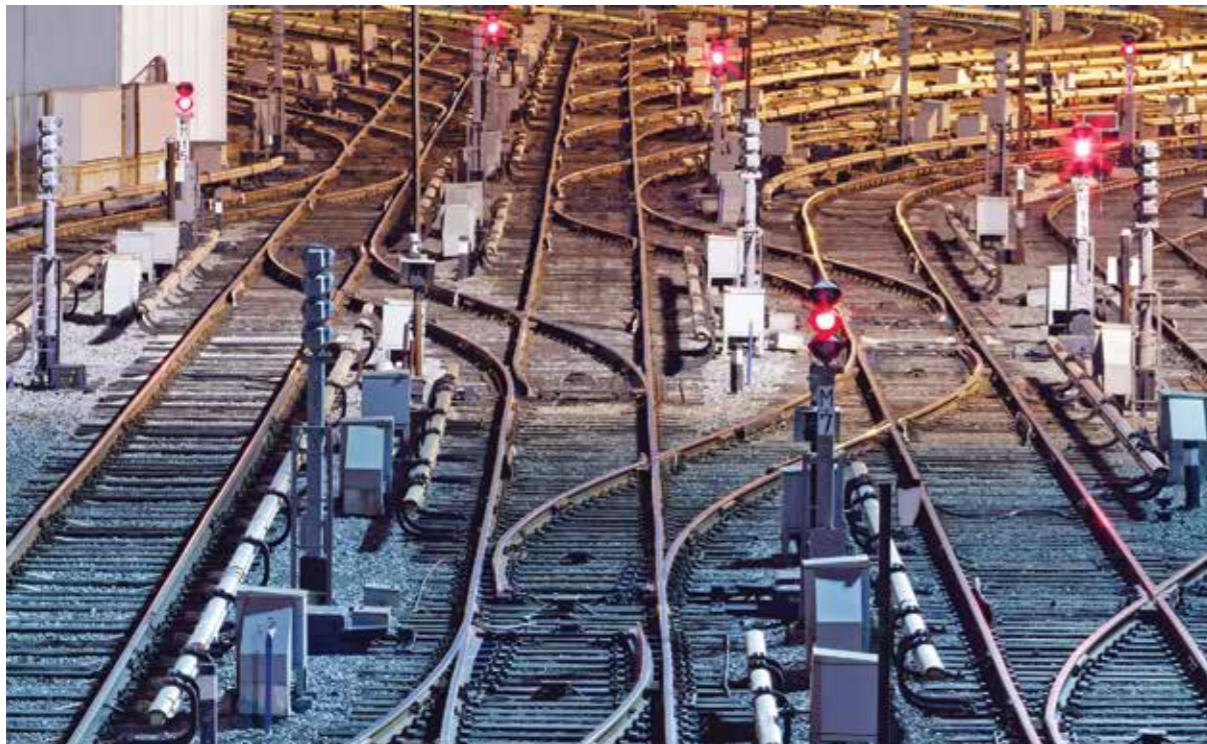
Золошлаки могут использоваться в железнодорожном строительстве
