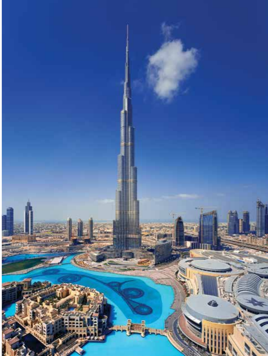
Башня Бурдж Халифа (г. Дубай, ОАЭ) построена с использованием бетона в смеси с золошлаками Источник: Sophie_James / Depositphotos.com
