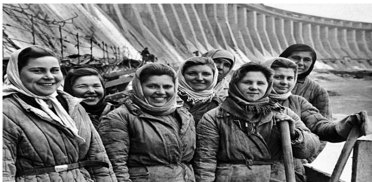
Строители Днепрогэса. 1930 г. Фотография.
