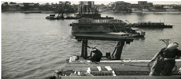
Строительство моста через р. Волгу. Г. Рыбинск. Фотография.
